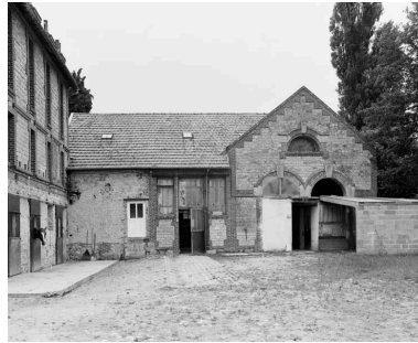
Chaufferie. Vue prise du sud. Phot. Pascal Corbierre IVR25_19951401506X
