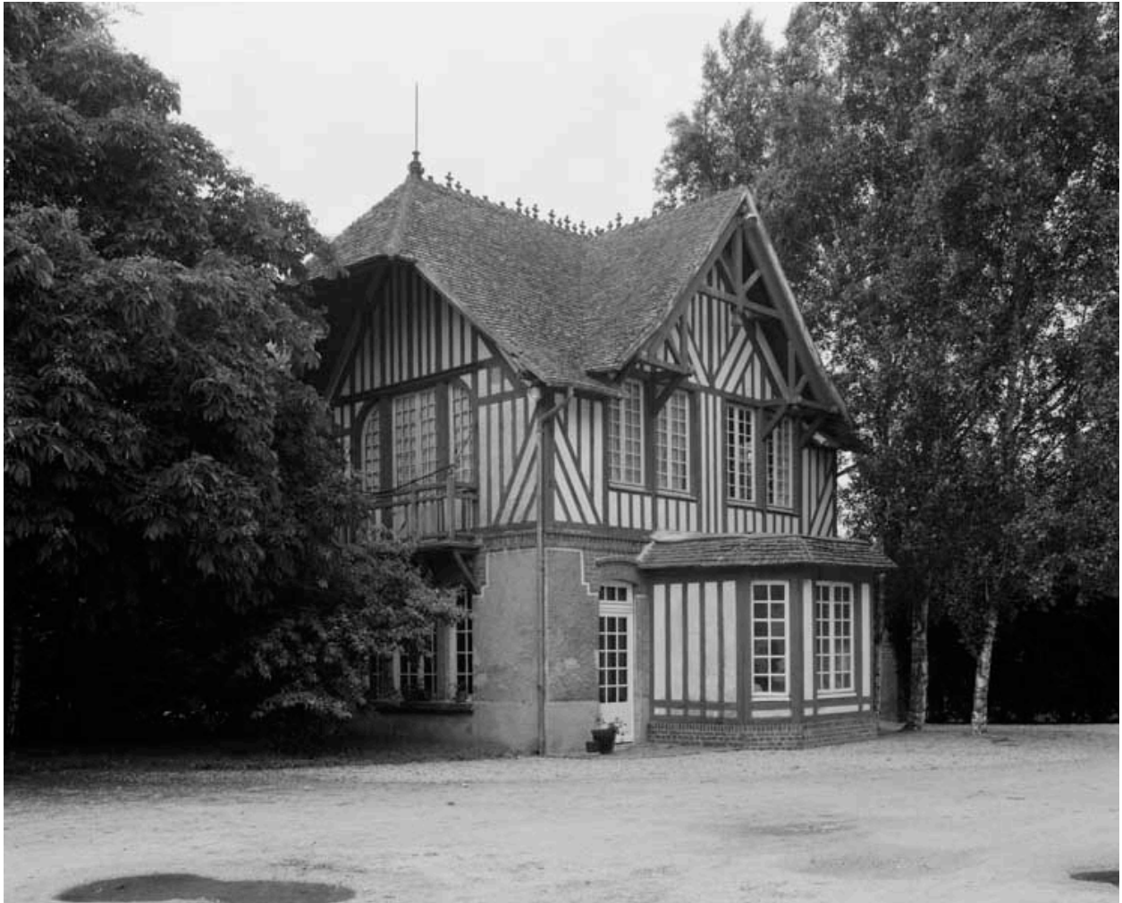
Bureau. Vue prise du sud.
