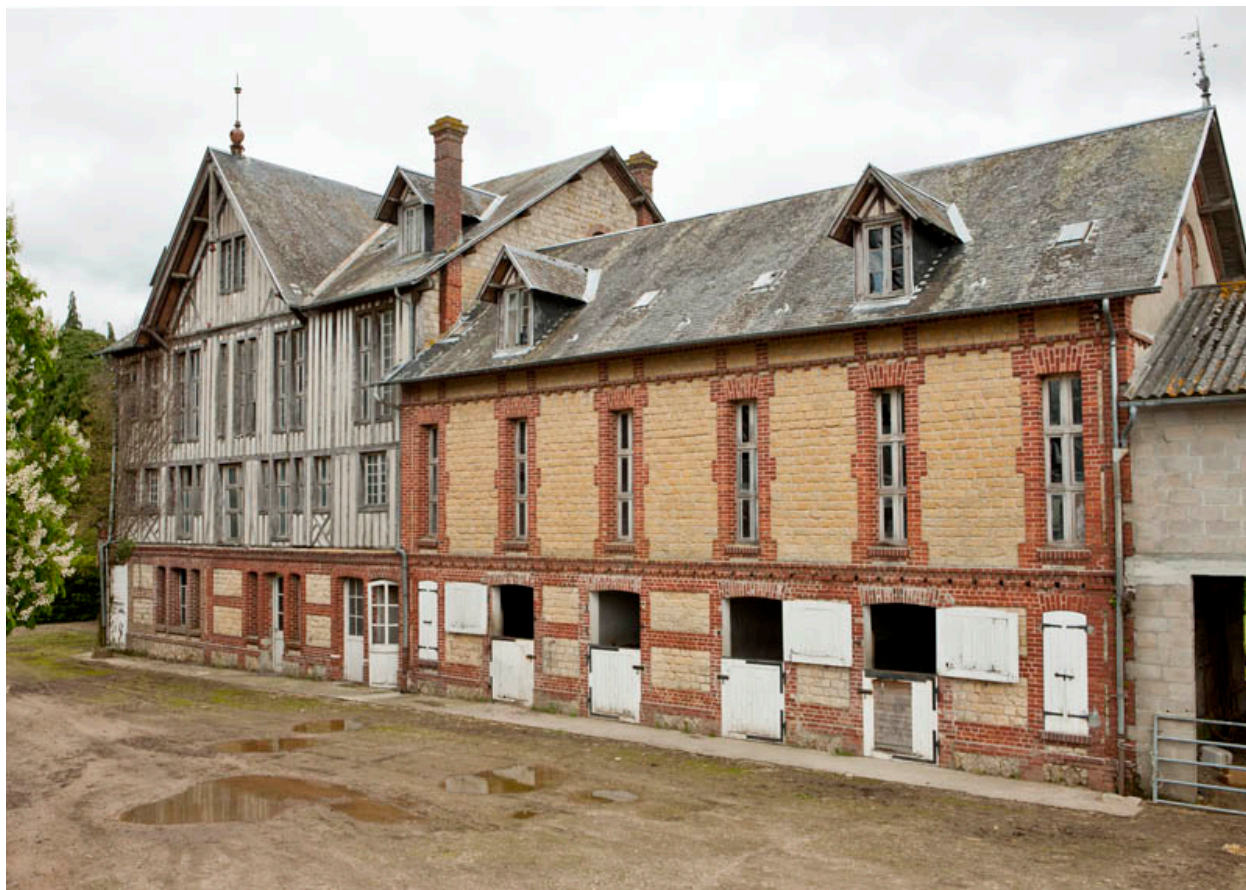
Pièces d'affinage (1) et (2). Vue prise du sud-ouest.
