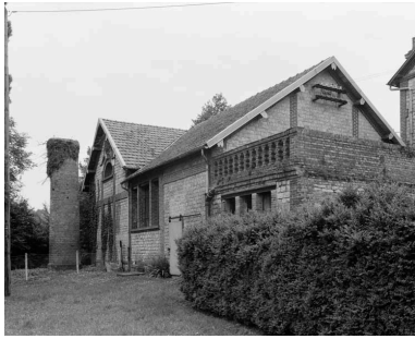
Chaufferie et cheminée d'usine. Vue prise du nord-ouest. Phot. Pascal Corbierre IVR25_19951401522X
