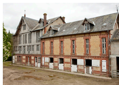
Pièces d'affinage (1) et (2). Vue prise du sud-ouest. Phot. Manuel de Ruyg IVR25_20121401100NUC2A
