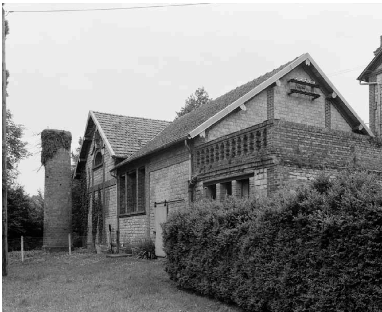
Chaufferie et cheminée d'usine. Vue prise du nord-ouest.
