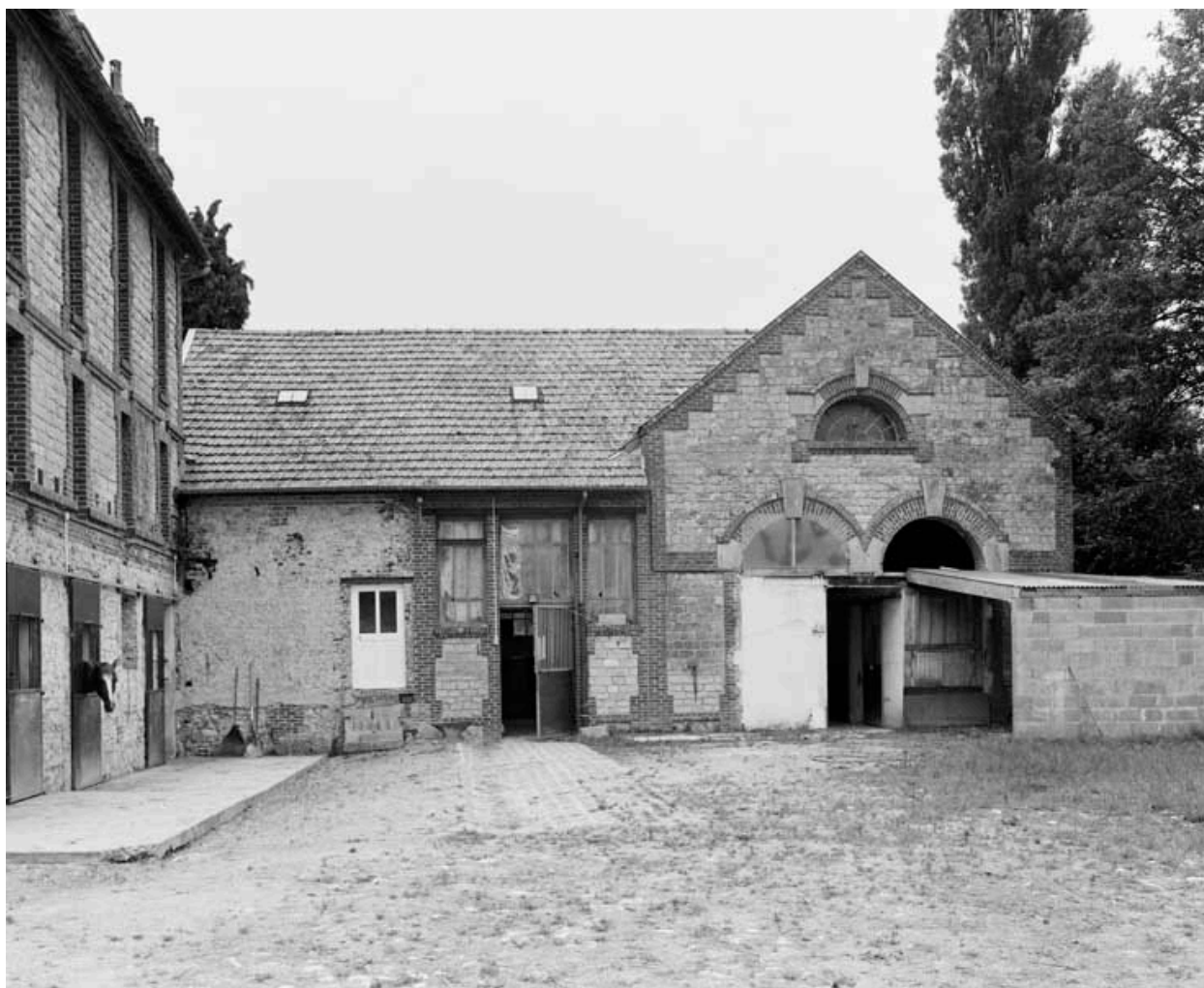
Chaufferie. Vue prise du sud.
