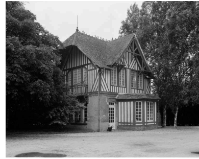
Bureau. Vue prise du sud. Phot. Pascal Corbierre IVR25_19951401521X
