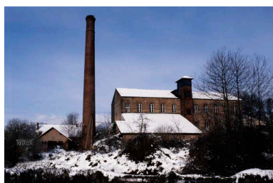
Vue d'ensemble prise de l'est. Phot. Philippe Bernouis IVR25_19871401274ZA
