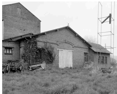
Remise de la filature. Vue prise du sud. Phot. Pascal Corbierre IVR25_19931401986X
