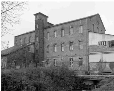
Bâtiment de la filature. Elévation extérieure est. Phot. Pascal Corbierre IVR25_19931401985X
