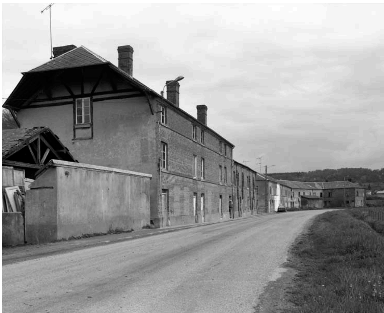
Logements d'ouvriers. Vue prise du nord.
