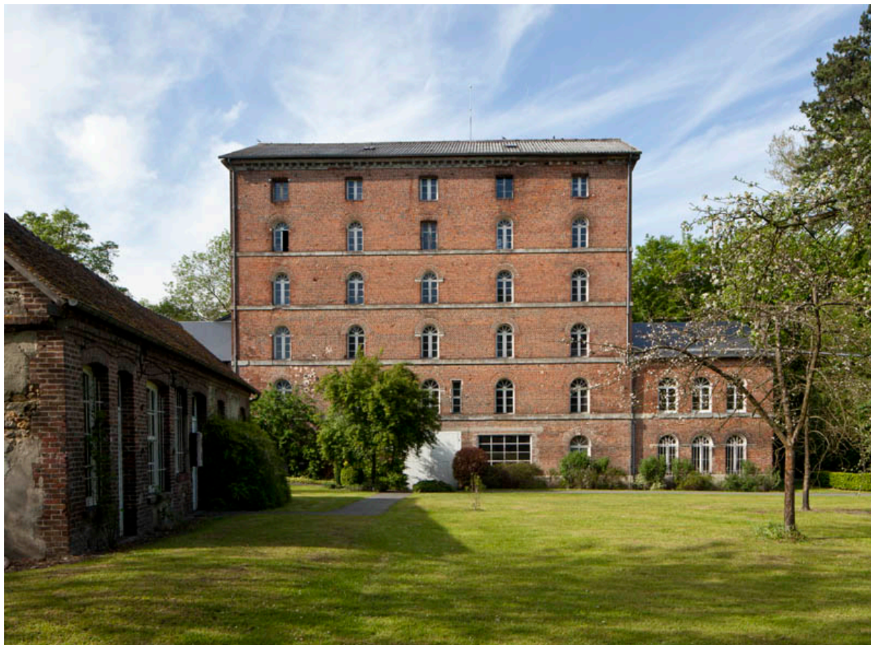
Bâtiment du moulin. Elévations extérieures sud.
