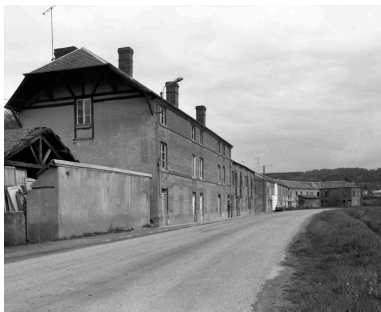
Logements d'ouvriers. Vue prise du nord. Phot. Pascal Corbier IVR25_19931402039X
