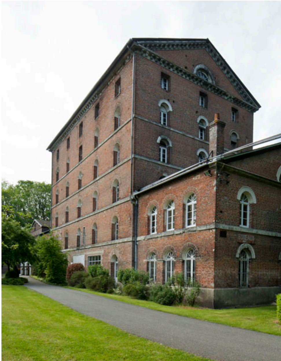
Bâtiment du moulin. Elévations extérieures sud et est.
