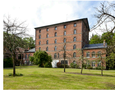
Bâtiment du moulin. Elévations extérieures sud et est. Phot. Manuel de Ruy IVR25_20121401059NUC2A
