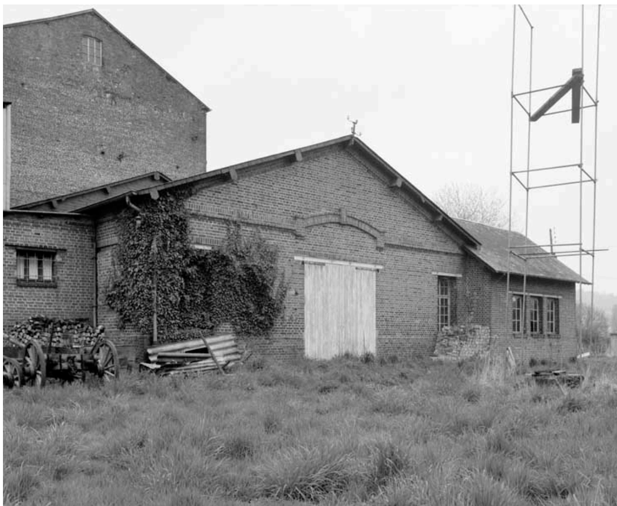
Remise de la filature. Vue prise du sud.
