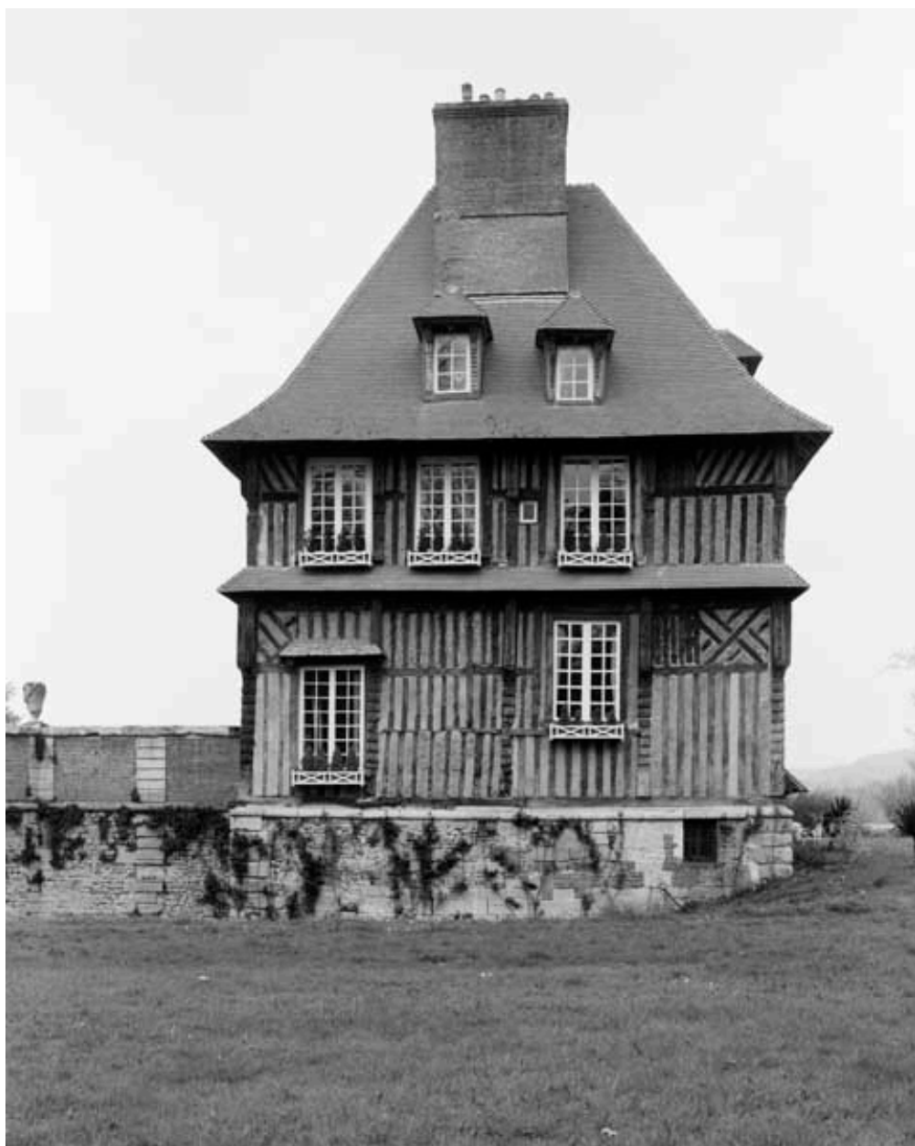
Château. Elévation extérieure sud.
