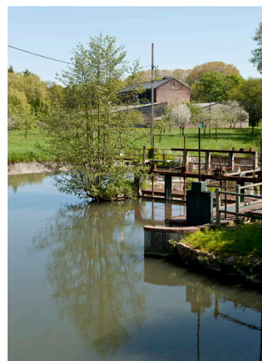
Vannages, vue du sud-ouest. Phot. Manuel de Rugy IVR25_20121401027NUC2A
