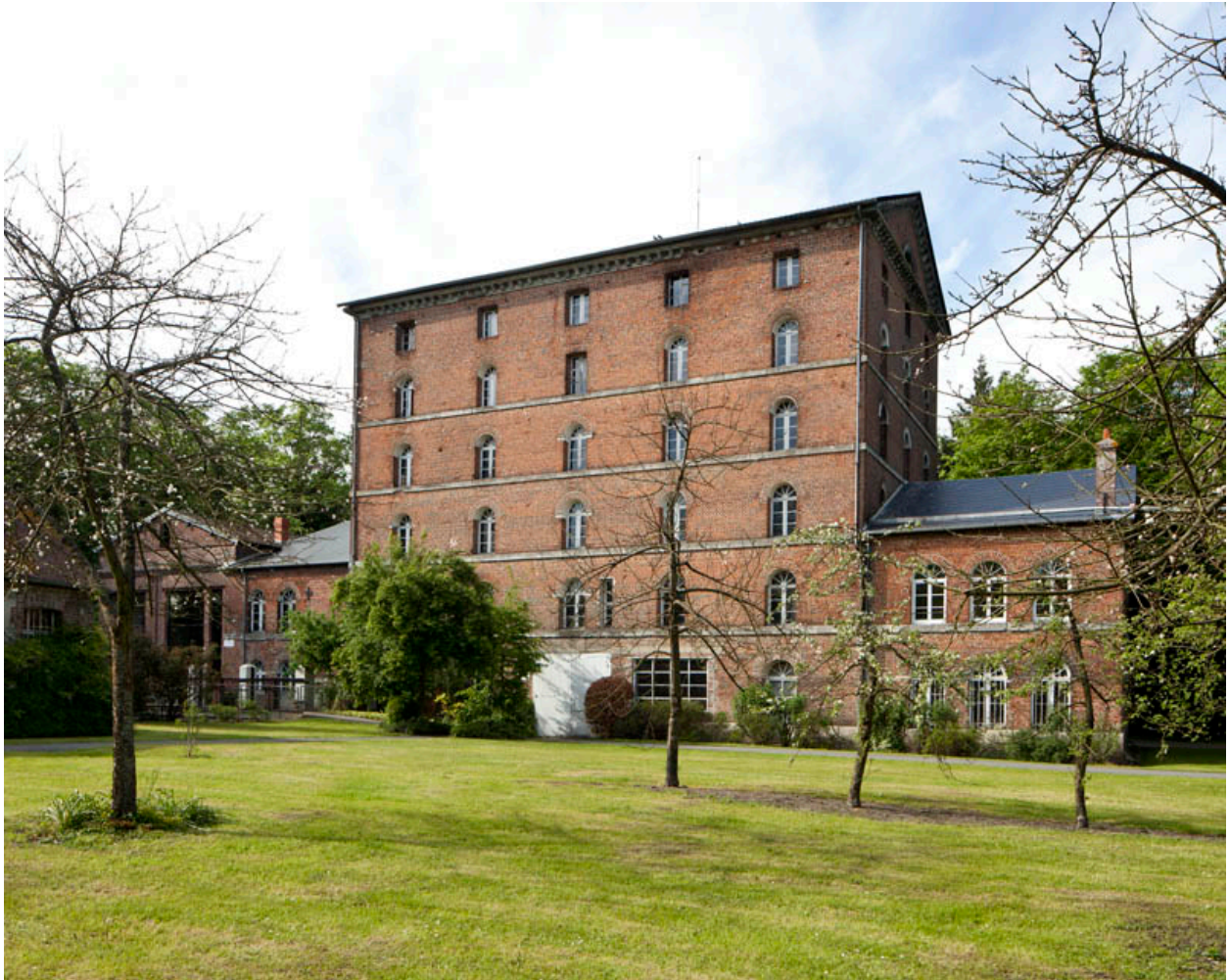
Bâtiment du moulin. Elévations extérieures sud et est.
