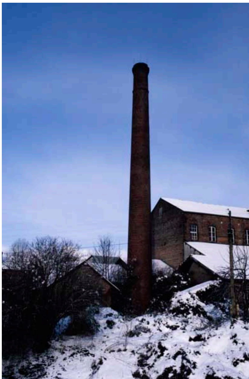
Cheminée d'usine, vue prise du nord.
