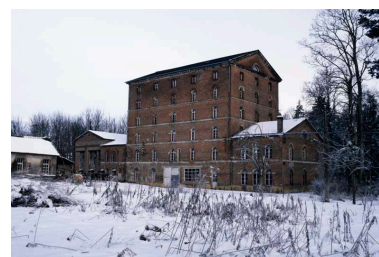
Bâtiment du moulin, vue prise du sud. Phot. Philippe Bernouis IVR25_19871401277ZA
