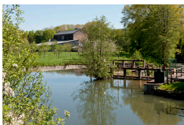
Vannages, vue du sud-ouest. Phot. Manuel de Rugy IVR25_20121401026NUC2A
