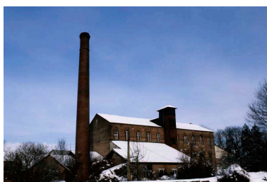
Vue d'ensemble prise de l'est. Phot. Philippe Bernouis IVR25_19871401275ZA
