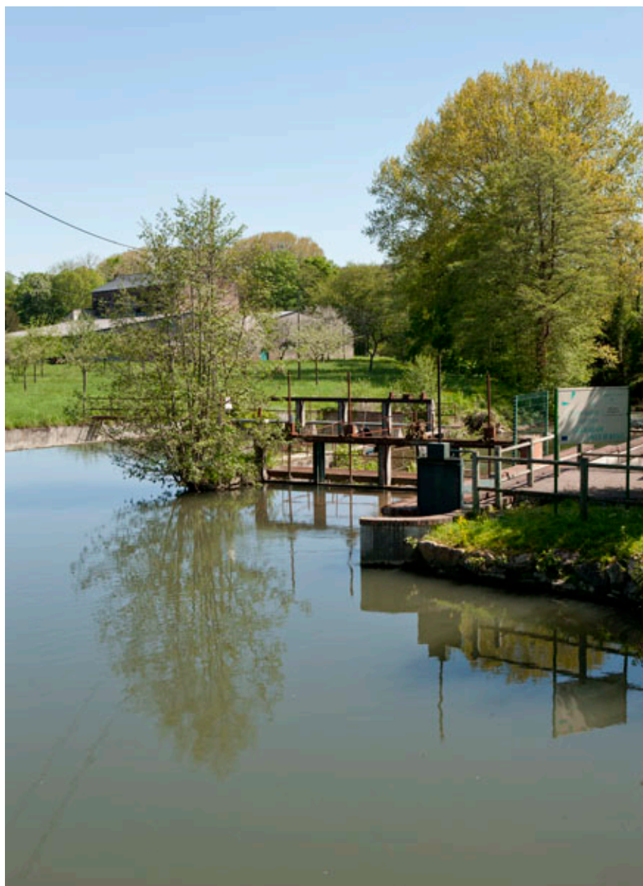
Vannages, vue du sud-ouest.
