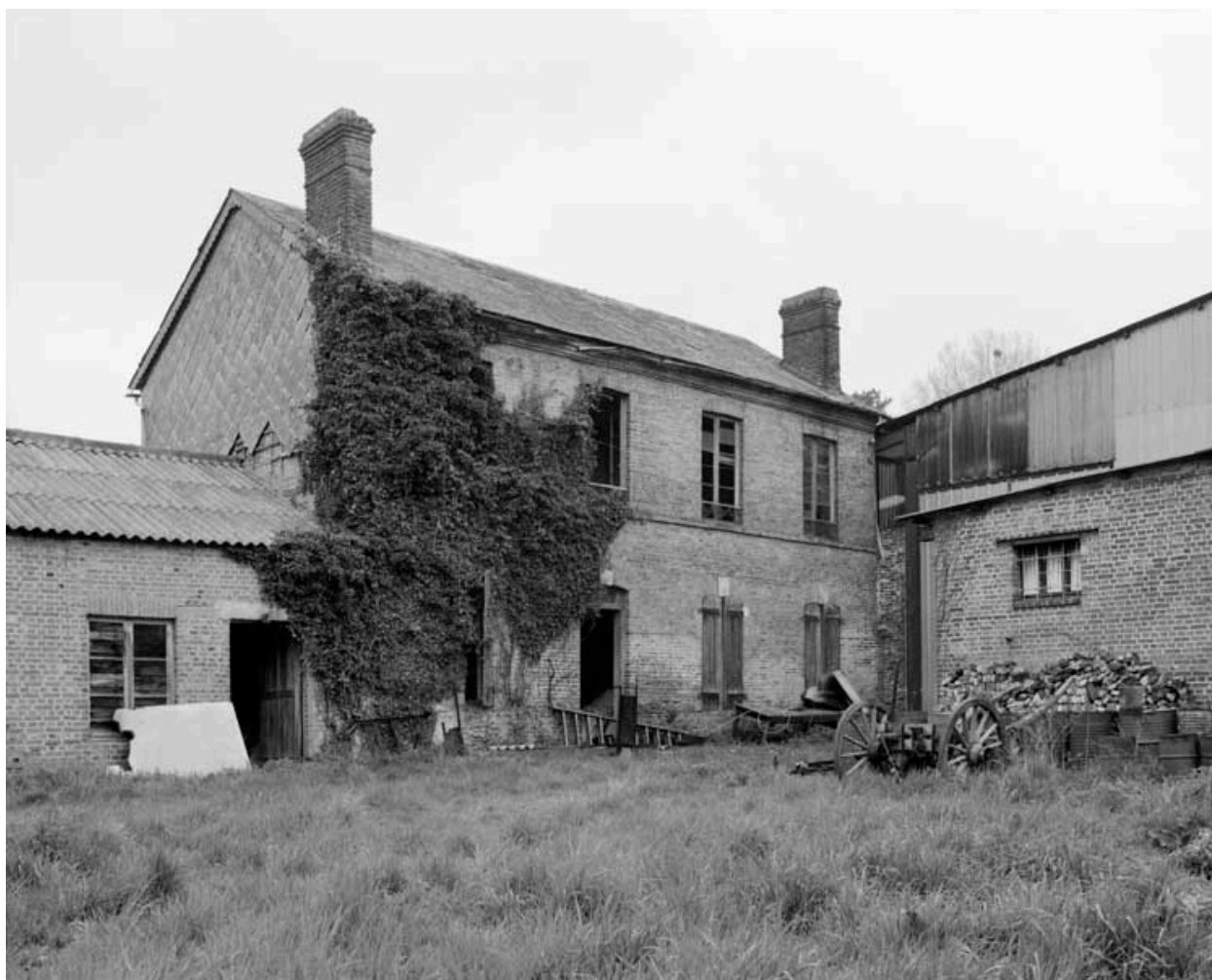
Logements d'ouvriers. Vue prise de l'est.
