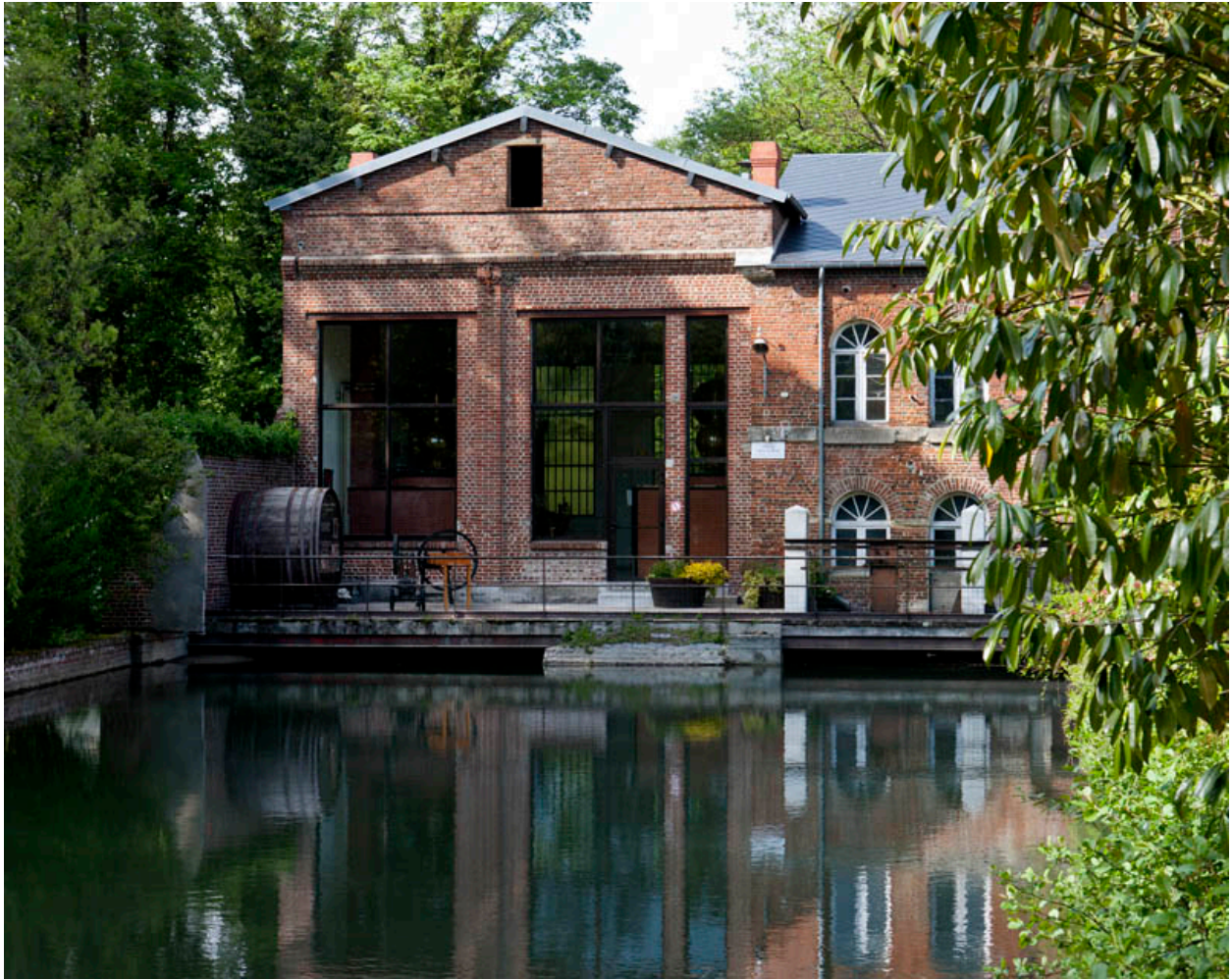
Bâtiment d'eau du moulin et salle abritant les machines à distiller. Elévations extérieures sud.
