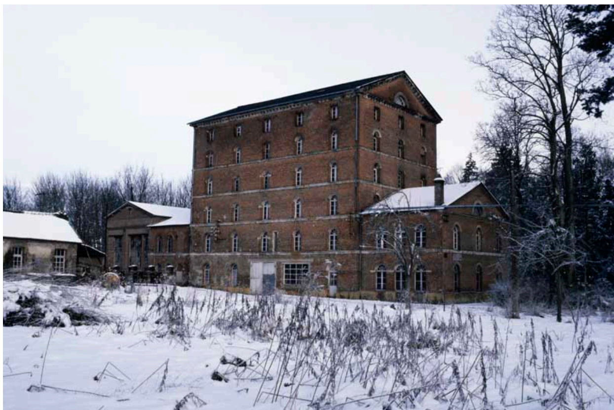
Bâtiment du moulin, vue prise du sud.
