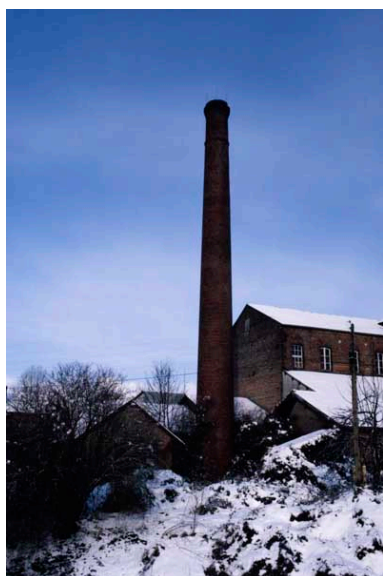
Cheminée d'usine, vue prise du nord. Phot. Philippe Bernouis IVR25_19871401276ZA
