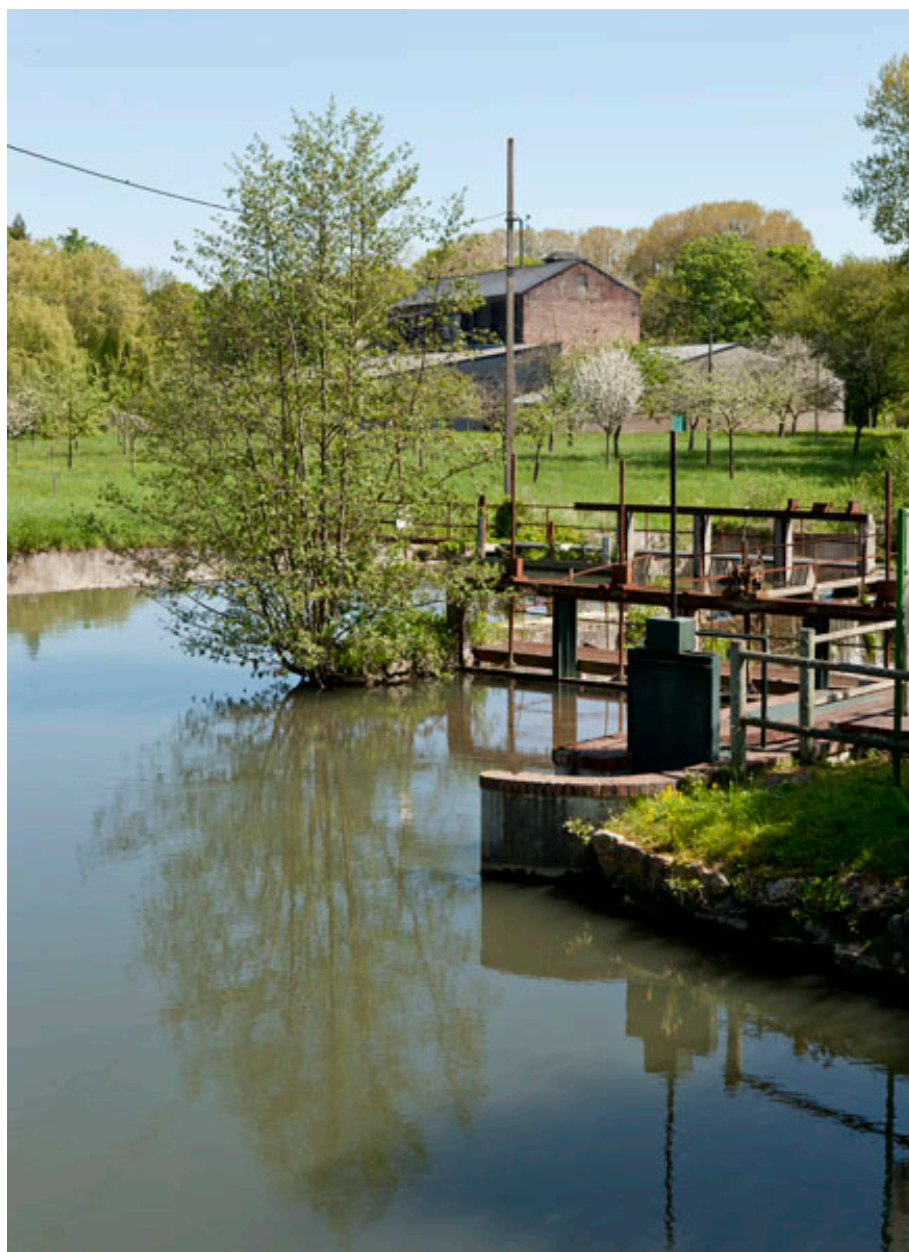
Vannages, vue du sud-ouest.
