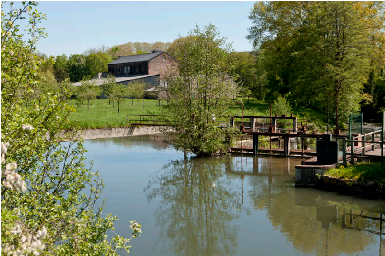
Vannages, vue du sud-ouest.
